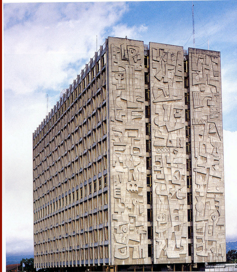
30.- Roberto González Goyri Fachada Banco de Guatemala, Sin título 1964-65 Concreto in situ , 40 x 21.63 mts, BANGUAT.
