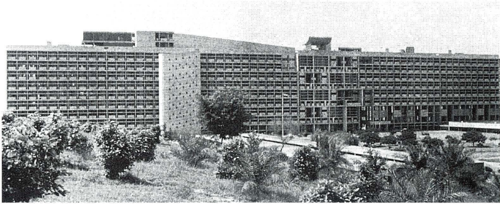
4.20. Le Corbusier, edificio del Secretariado, Chandigarh (India), 1951-1958. En este alargado edificio, Le Corbusier varió el ritmo y la forma de los brise-soleils en la parte central, rompiendo así la desmesurada dimensión horizontal de la fachada.
