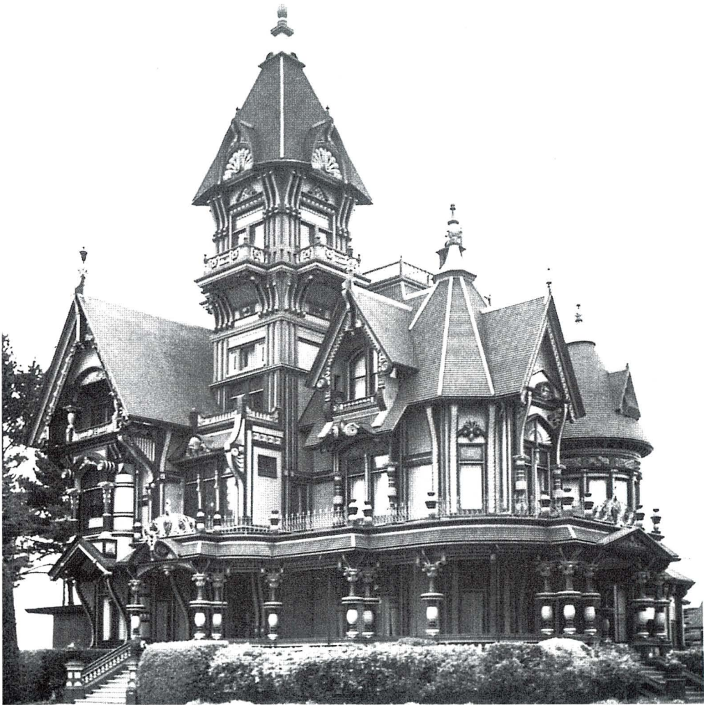
4.28. Samuel y Joseph Newsom, casa William M. Carson, Eureka (California), 1884-1885. Esta elaborada casa fue construida enteramente en madera de secuoya, para demostrar la extrema versatilidad de esta duradera madera blanda y también para mantener ocupados a los empleados del aserradero de madera de Carson, durante un periodo de recesión económica.
