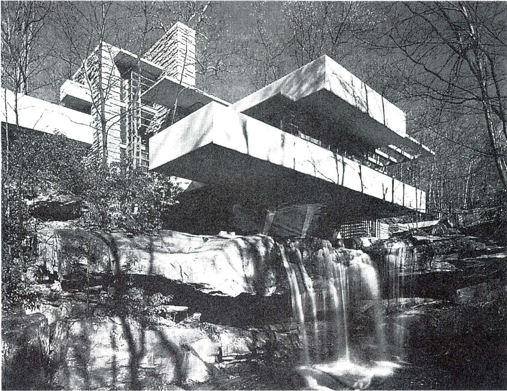
4.24. Frank Lloyd Wright, casa de Edgar Kaufmann llamada casa de la Cascada, cerca de Mill Run (Pensilvania), 1936-1938. Obsérvese el vigoroso contraste entre los machones verticales de mampostería (con sus piedras aparejadas imitando los estratos naturales de la roca) y las lisas superficies horizontales de hormigón.
