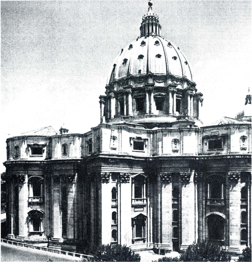
4.16. Miguel Ángel, basilica de San Pedro. Extremo oriental. Con objeto de unificar visualmente este gran edificio, Miguel Ángel empleó deliberadamente elementos sobredimensionados, a fin de reducir el número de partes, pero el resultado obtenido dificulta la lectura de la escala real del edificio con relación a la escala humana.
