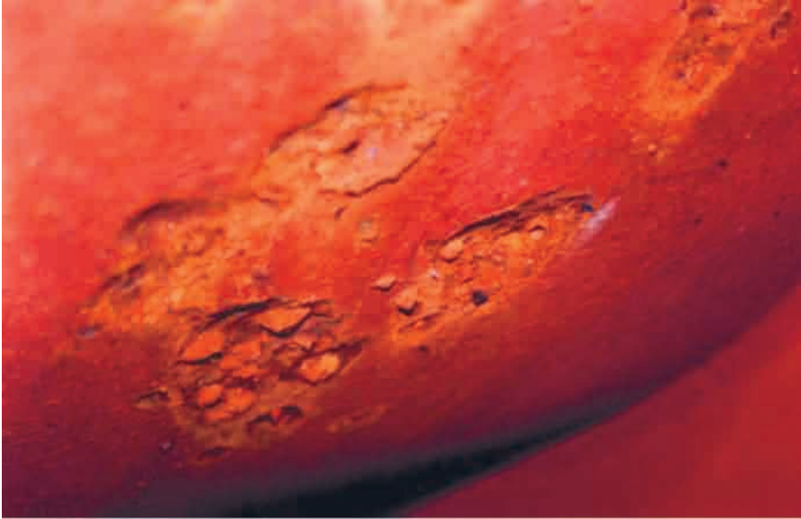
Foto 3.4. Ejemplo de corrosión cáustica en tubo hogar de caldera de vapor.
