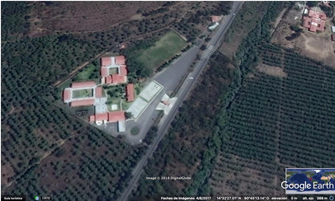
Vista general, con RN 14 a la derecha.
