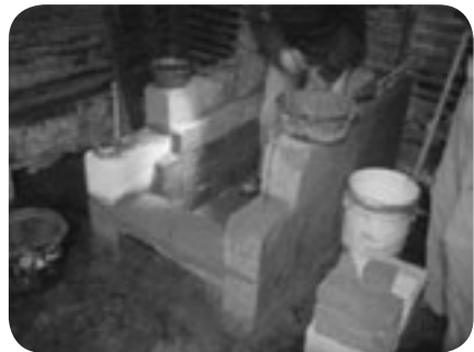
Estufa modelo CYSTEM. Fabricación de la estufa de Pasajquim.
