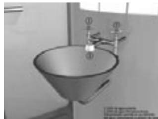
Detalle de Lavamanos.
