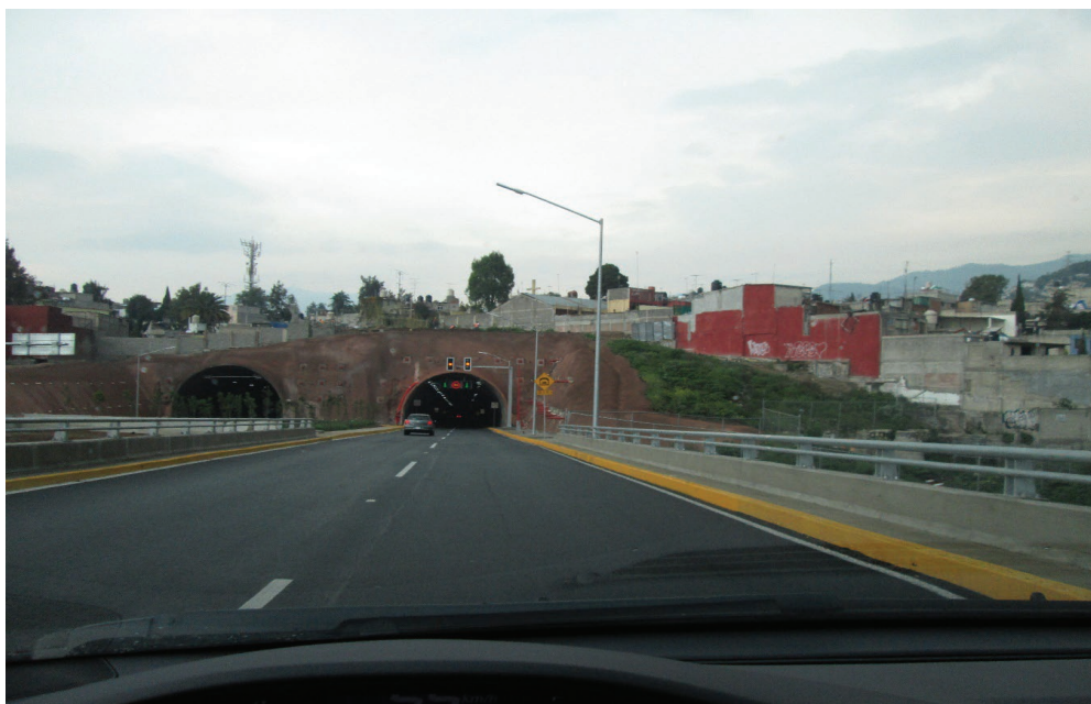
El túnel más largo de la Supervía Poniente pasa por debajo de la colonia La Malinche. Fotografía: Margarita Pérez Negrete.
