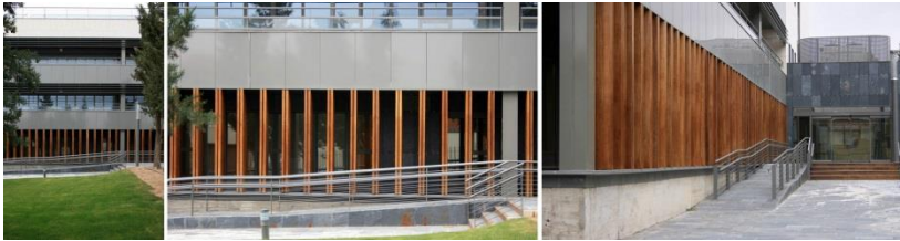
Elementos de madera para la protección del viento fuerte de la región www.plataformaarquitectura.cl (2009)
