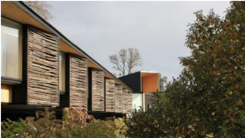
Vista exterior de las habitaciones www.plataformaarquitectura.cl (2013)
