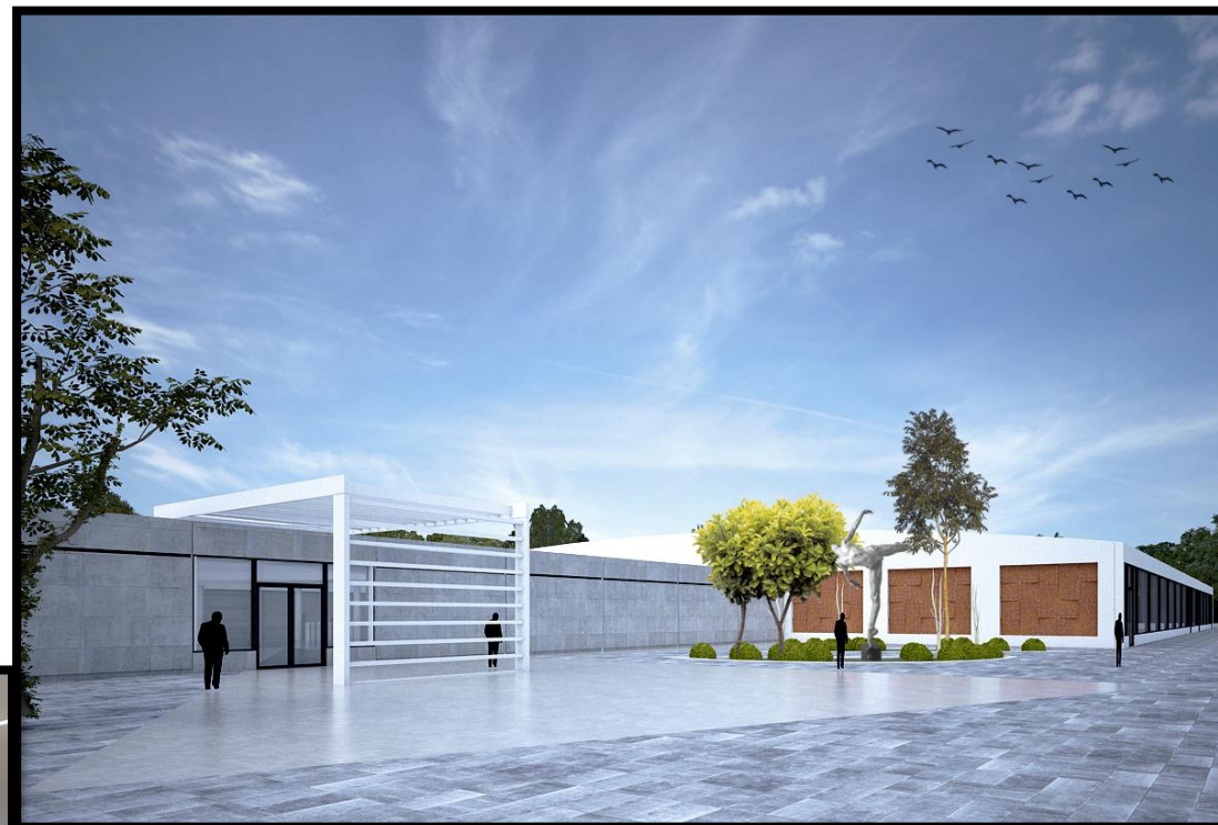
VISTA DE EXTERIOR
