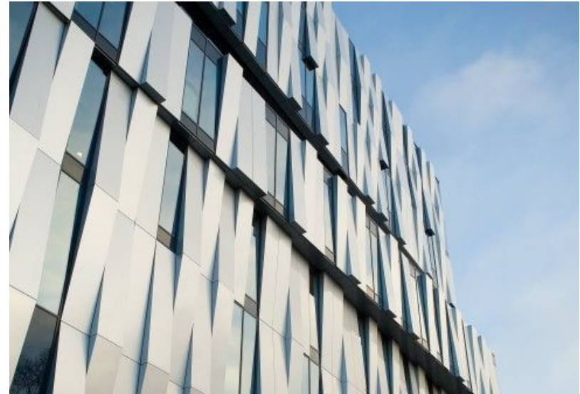
Fachada de Alucobond (23)
