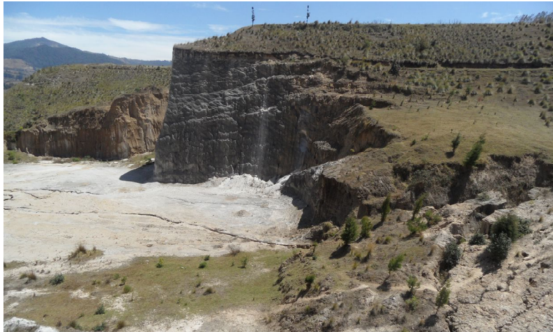
Fotografía 1: Vista de la cortada de mayor dimensión en el terreno.
