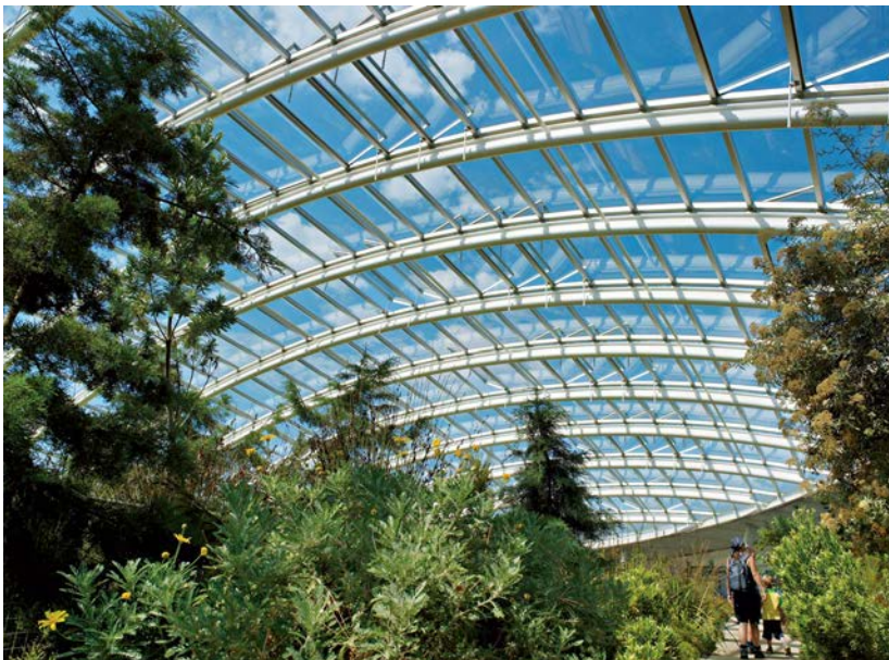
Imagen 37 Estructura longitudinal Fuente:
