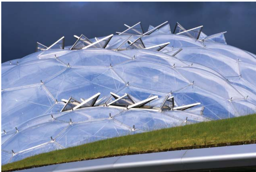
Imagen No. 24 Ventilación e iluminación Fuente:
