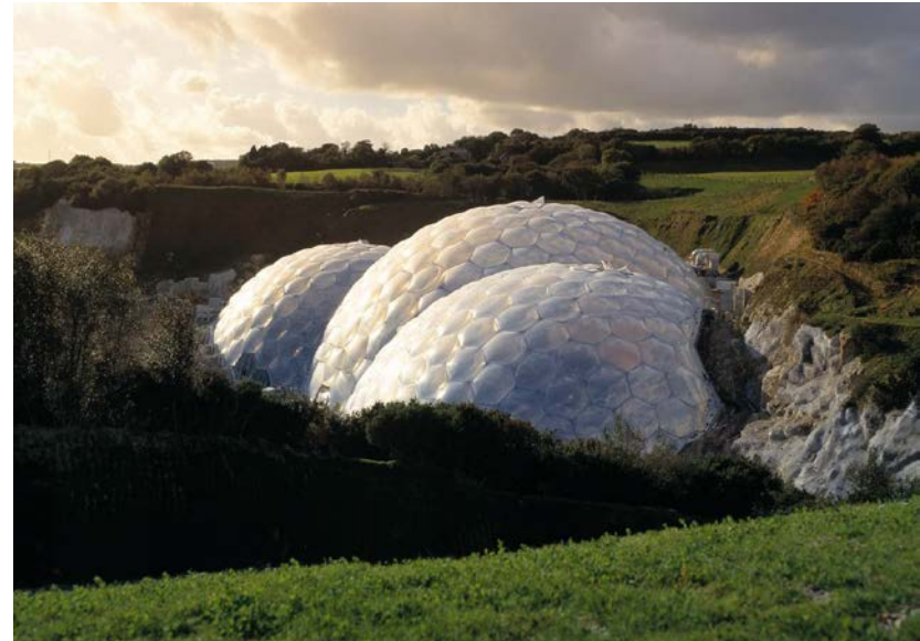
Imagen No. 25 Ventilación e iluminación Fuente:
