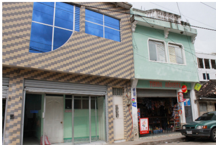
Tienda de la localidad. Nótese el contraste de construcciones. Fotografía: María Fernanda López Ruano
