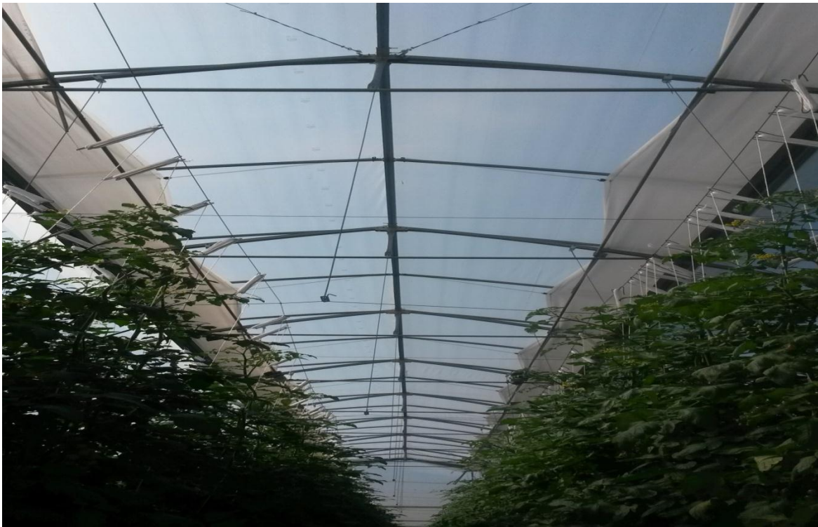
Foto 2. Parte superior de un Invernadero con Ventana cenital diseño Mariposa
