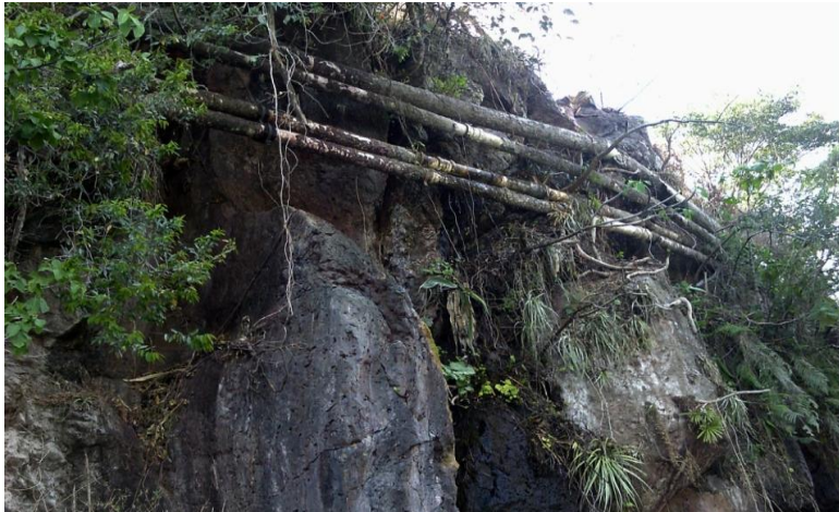
Figura 22. Vulnerabilidad a deslizamientos de la red de distribución del sistema de abastecimiento de agua potable
