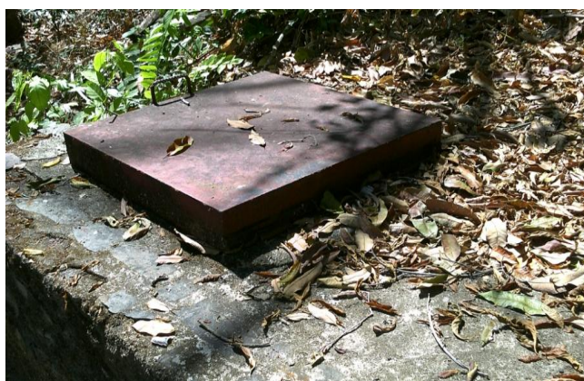
Figura 14. Muestra que el tipo de la obra de captación es de concreto y en buen estado
