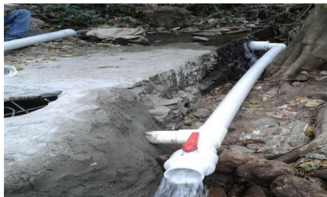
Figura 13. Mantenimiento realizados por los fontaneros a las obras de captación para mantenerlas en buen estado
