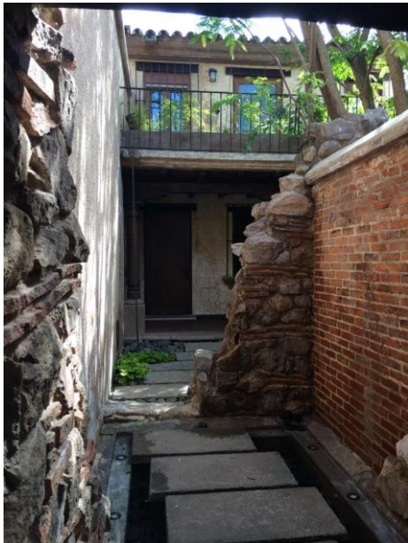
Imagen 28 'el Convento' Fuente Propia (2015)
