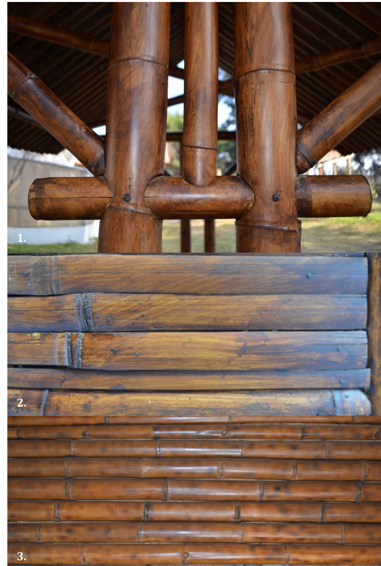
Imagen 60. 1- Detalle de unión en kiosko, vara con tinte y barniz. 2-Detalle de varas con quemado claro, tinte y barniz. 3- Detalle de varas quemadas recubiertas solo con barniz. Fuente: propia
