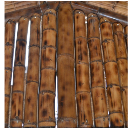
Imagen 14. Detalle interior del techo, oficina de bambú. Fuente: propia
