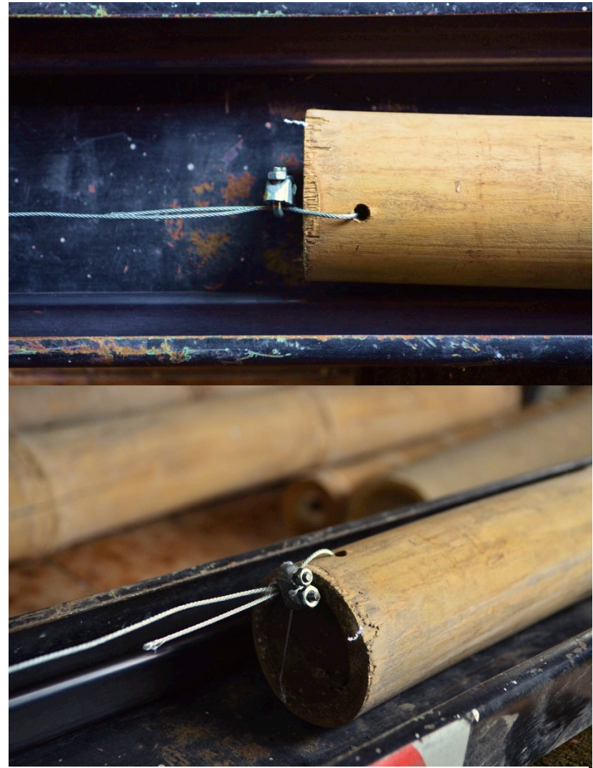
Imagen 131. Detalle de orificio y amarre de cable. Fuente: propia.
