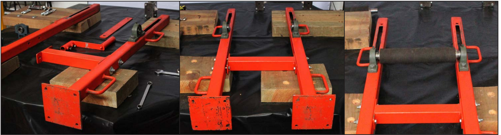
Imagen 237. Secuencia de colocado de estabilizador inferior, postes, chumaceras y eje inferior. Fuente: propia
