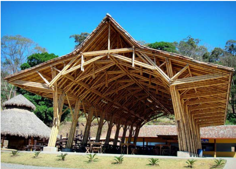
Imagen 10. Detalle interior de rancho de bambú. Fuente: http://www.guadubamboo.com/construction/ Fecha de recuperación: 12/2/2014
