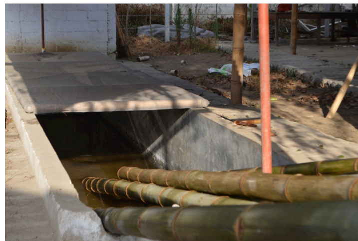
Imagen 35. Tanque de inmersión de la finca El Morón, con varas escurriendo. Fuente: propia
