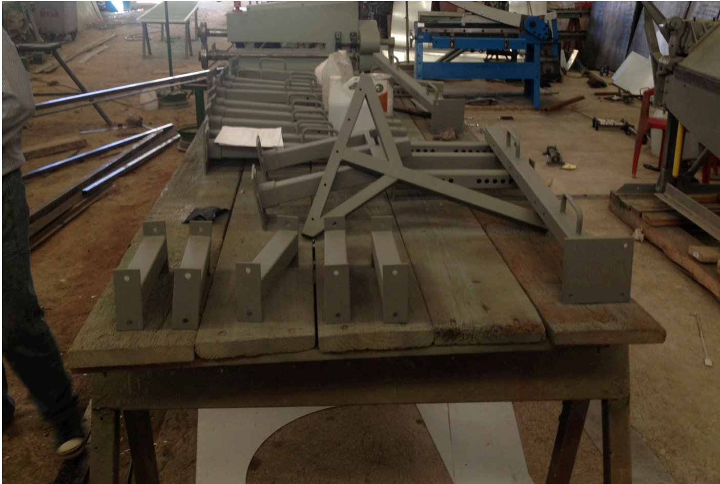
Imagen 218. Piezas con fondo anticorrosivo aplicado. Fuente: propia
