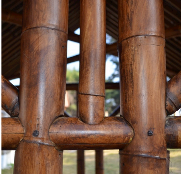
Imagen 70. Varas de bambú quemadas recubiertas con tinte y barniz. Fuente: propia
