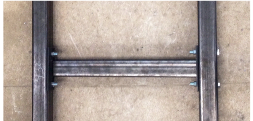
Imagen 213. Comprobación de encajado de perforaciones de platinas y tubos. Fuente: propia
