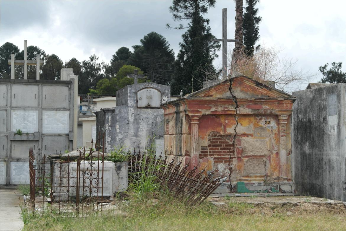
Mausoleos abandonados. Se observan cuarteaduras en la estructura y reja de hierro colapsada.
