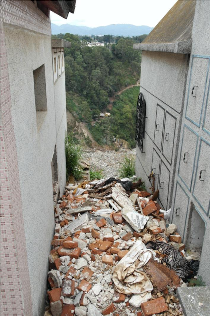
Vista del área de mausoleos colapsada. El corte en el suelo es vertical y finaliza directamente en el relleno sanitario.
