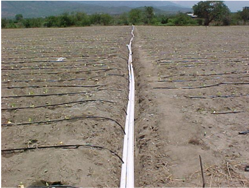
Figura 17. Detalle de instalación de línea principal, secundaria y cinta de riego. Fuente: El Autor.
