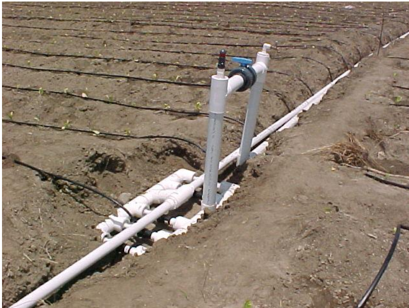
Figura. 16 Detalle de instalación de sistema de riego por goteo. Fuente: El Autor.
