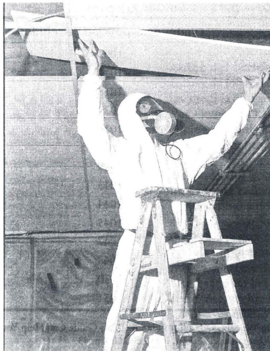
La exposición a los asbestos es una importante fuente potencial de enfermedades respiratorias laborales. Este trabajador utiliza ropa protectora y un respirador al quitar el asbesto de los paneles del techo de un salón de clases.
