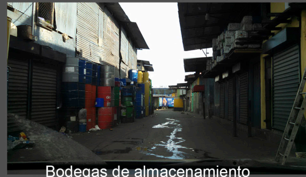
Bodegas de almacenamiento
