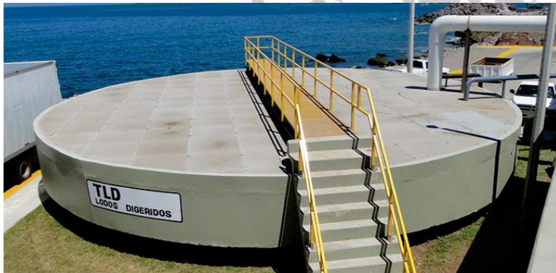
Imagen No. 33. Tratamiento de lodos. Fuente: http://jumapam.gob.mx/planta-tratadora-el-creston/ . Fecha de consulta: 23 de noviembre de 2016
