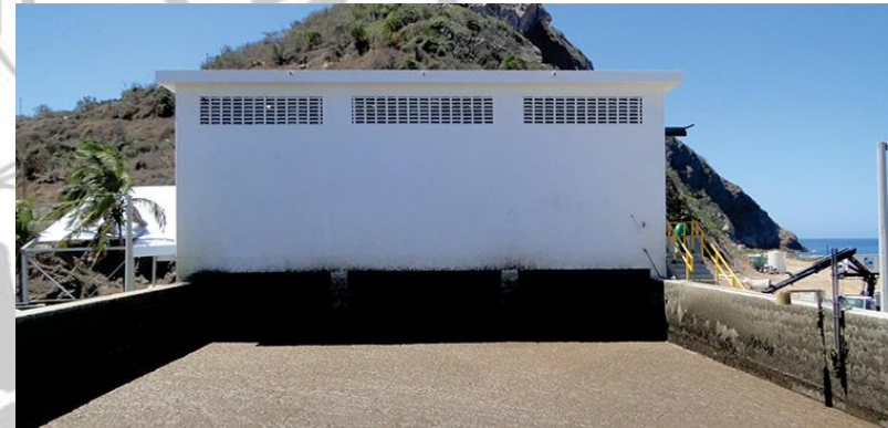
Imagen No. 32. Cárcamo y caja de cárcamo. Fuente: http://jumapam.gob.mx/planta-tratadora-el-creston/ . Fecha de consulta: 23 de noviembre de 2016
