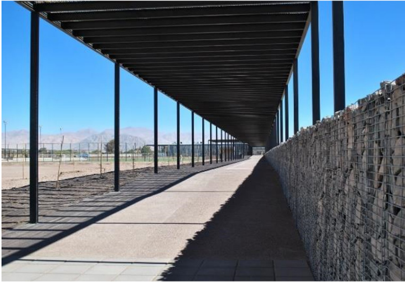
Encaminamiento entre las canchas deportivas
