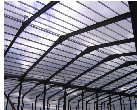
Imagen 42. Ejemplo de estructura en acero
