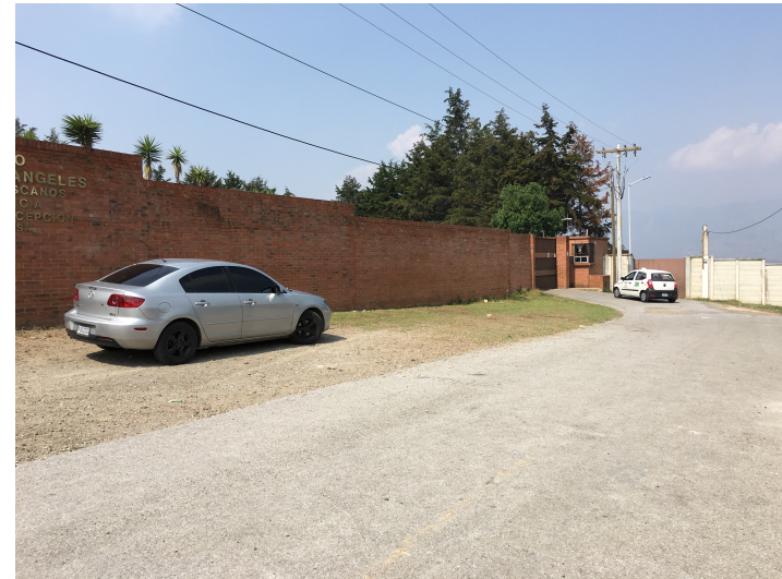
Imagen 78. Ingreso principal al Orfanato Fuente: propia, 2017.
