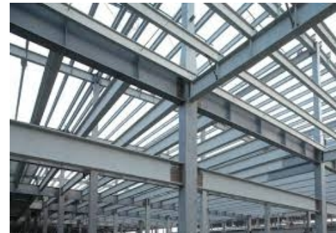
Imagen 41. Ejemplo de estructura en acero
