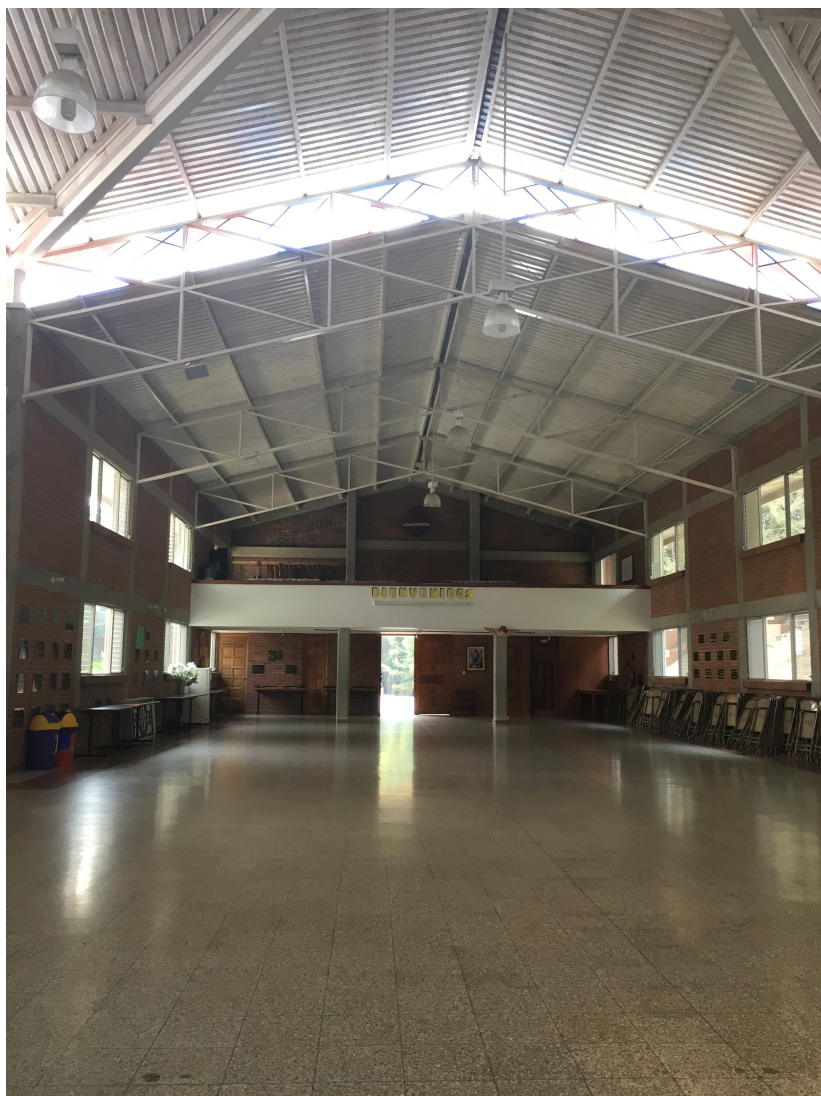
Imagen 97. Vista de Salón de Usos Múltiples – Ala principal Fuente: propia, 2017
