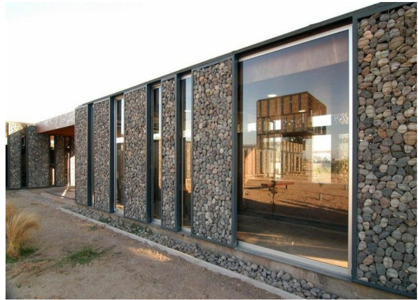
Imagen 50. Ejemplo de parte luz con muro de gaviones
