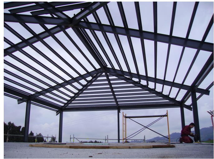
Imagen 43. Ejemplo de estructura en acero
