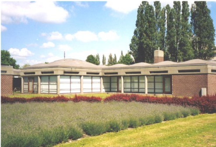
Imagen 55. Edificio de Orfanato de Ámsterdam.
