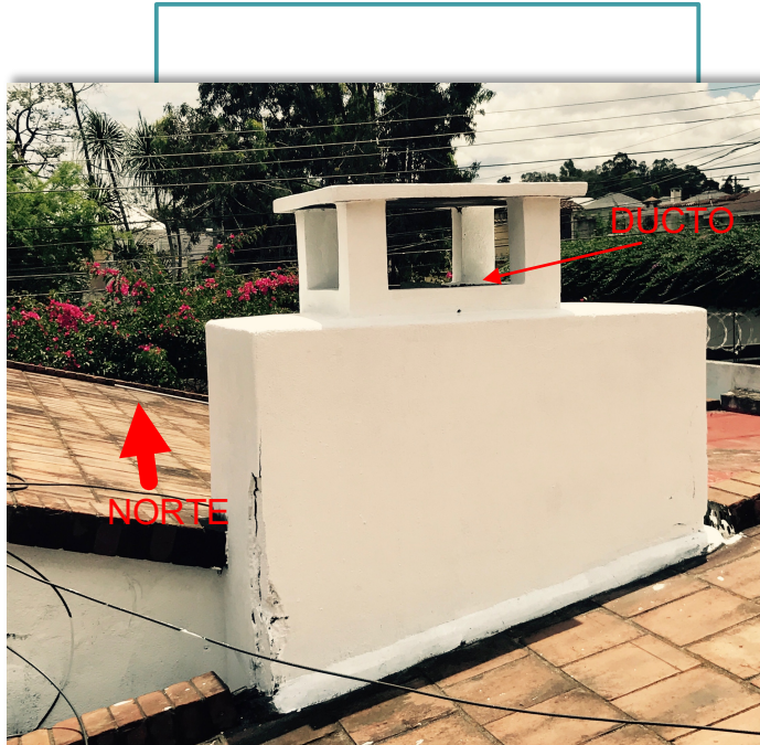
Imagen 12 Exterior de la chimenea
