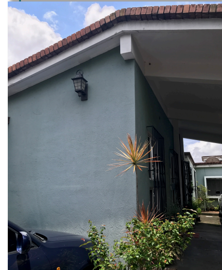
Imagen 9 Fachada de la Vivienda Z12
