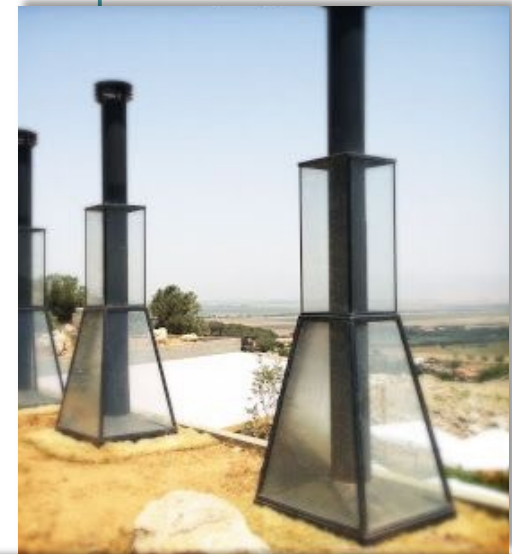
Imagen 2 Chimenea Solar en Líbano Fuente: http://pin.it/ULZ2F9f
