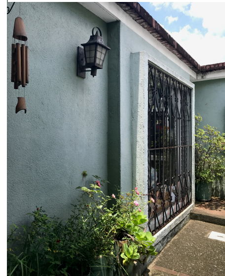
Imagen 10 Fachada de Sala de la Vivienda Z12
