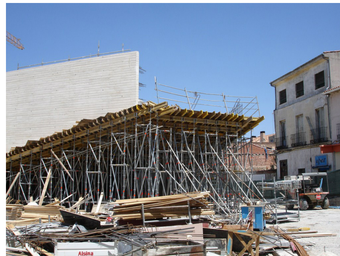
Construcción del Nuevo Centro Cultural
