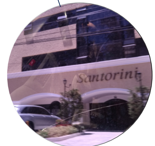
Edificio de apartamentos Santorini Fotografía: Javier García
