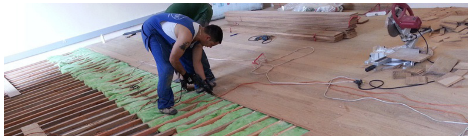
Instalación piso para danza
