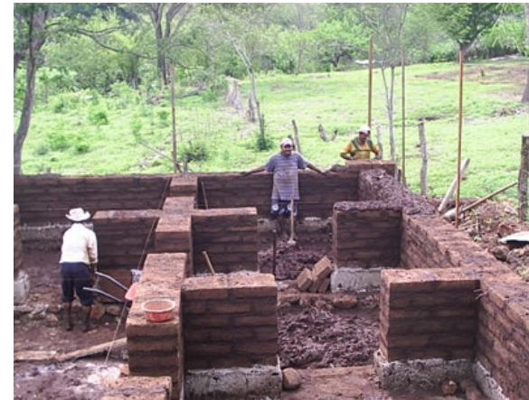
Proceso de construcción de adobe. Foto por: http://www.ecosur.org/
