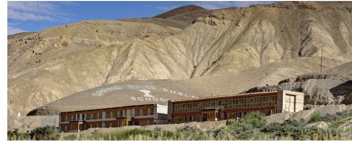
Escuela construida con tapial, Asia Foto por: archide
