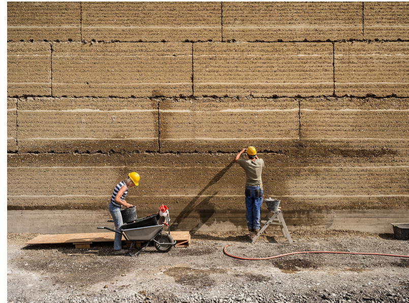
Saneamiento de juntas Foto por: Ricola
