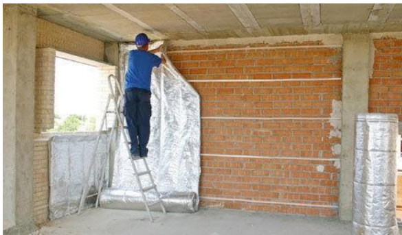
Instalación de aislante térmico en vivienda pasiva fuente: Renueva verdes .inc
