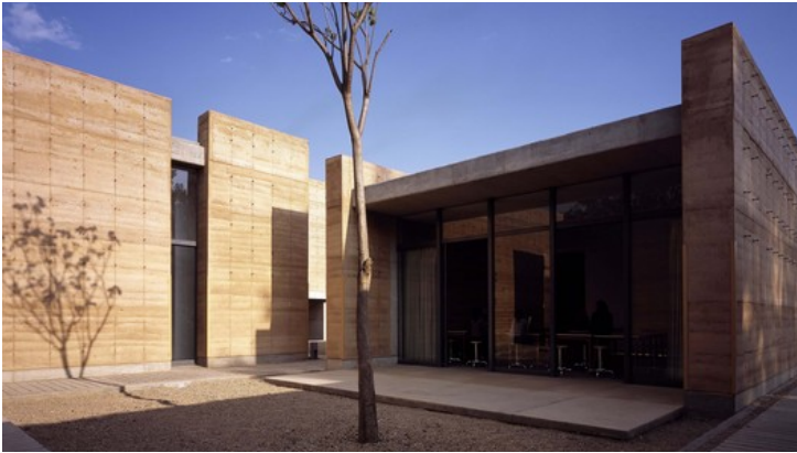
Muros de tapial
