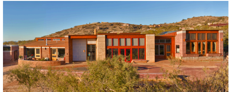
Casa construida con muros de tapial Foto por: http://www.rammedearthhomes.com/
