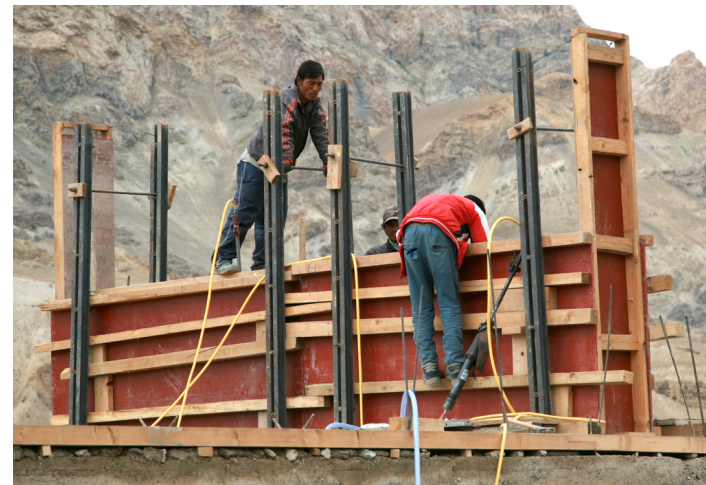
Encofrado de tapial Foto por: archide.
