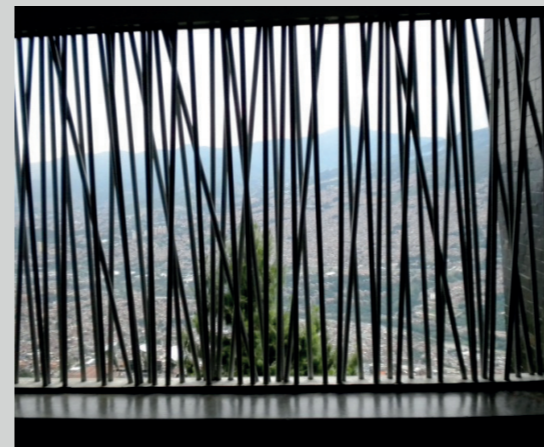
Estructura Metálica. (Febrero 2017). Disponible en: https://regresoacolombia.wordpress.com/category/medellin/santodomingo/
