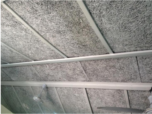
Imagen No. 52: Recubrimiento de fibra en cubiertas. Fuente: Propia.
