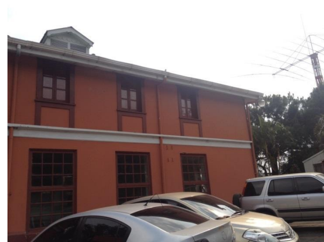
Imagen No. 26: Edificio que resguarda equipo sismológico en el sótano. Fuente: Propia.
