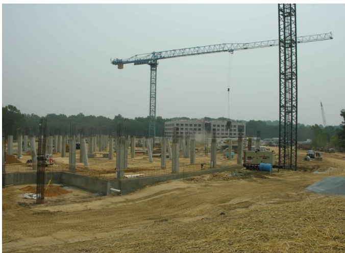
Imagen No. 97: Proceso de levantado de columnas el 19 de junio de 2007. Fuente: http://www.ncep.noaa.gov/news/ncwcp/s007_images/s007e_20070619.jpg
