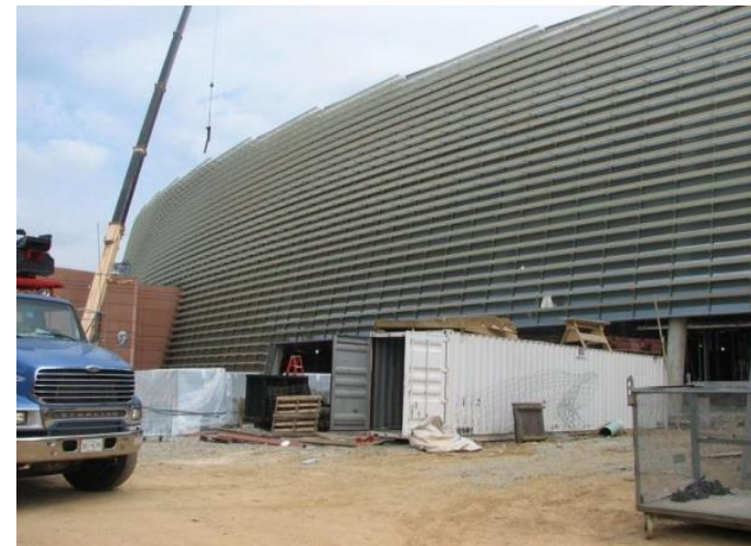
Imagen No. 103: Colocación de estructura metálica en fachada frontal, el 23 de julio de 2008
