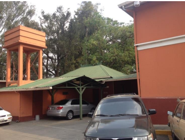
Imagen No. 25: Área de estacionamiento. Fuente: Propia.
