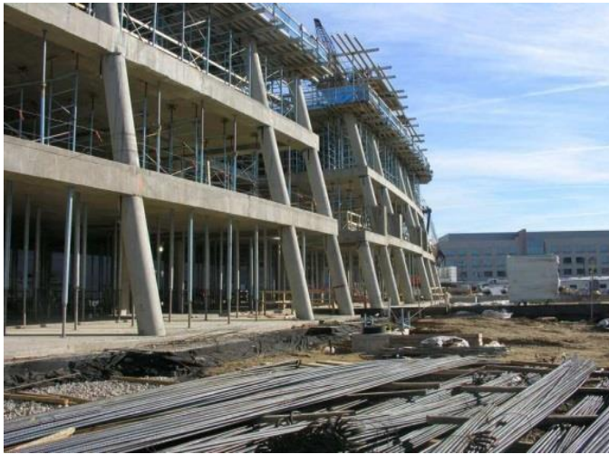
Imagen No. 100: Armazón estructural de los primeros dos niveles, el 30 de noviembre de 2007.
