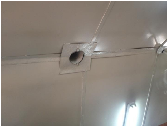
Imagen No. 48: Ducto de extracción de extracción y ventilación. Fuente: Propia.
