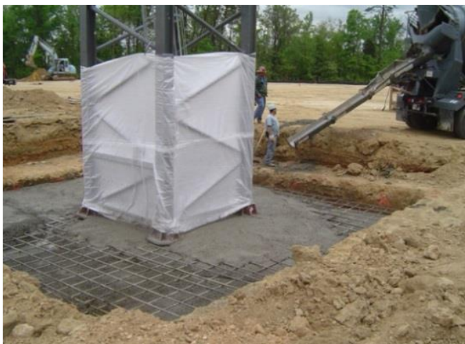
Imagen No. 96: Proceso de fundición de zapatas 29 de mayo de 2007 Fuente: http://www.ncep.noaa.gov/news/ncwcp/s003_images/s003h_20070509.jpg
