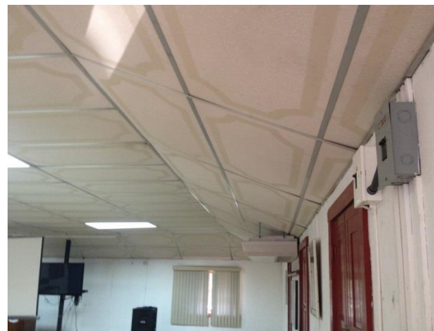
Imagen No. 46: Detalle de la cubierta del área de conferencias.
