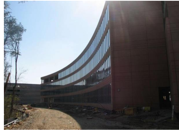
Imagen No. 102: Colocación de ventanales, 25 de marzo de 2008
