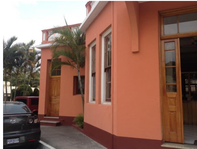
Imagen No. 23: Fachada lateral del edificio principal.
