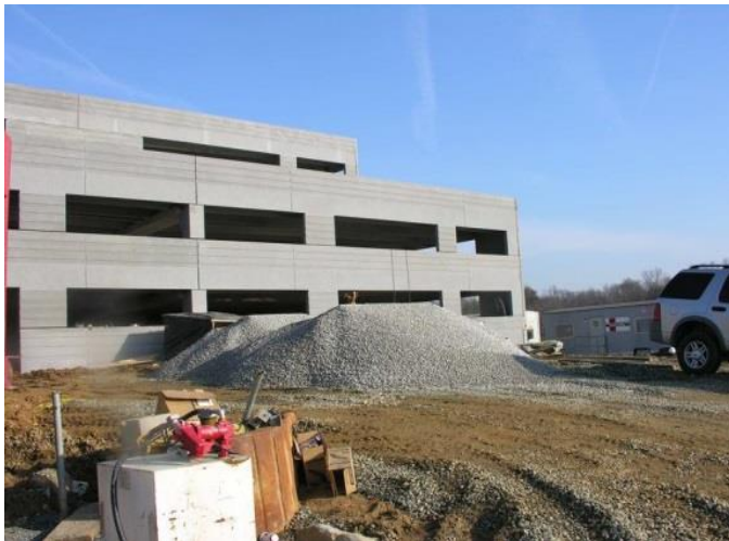
Imagen No. 101: Proceso de repellaje, 28 de diciembre de 2007.
