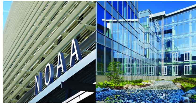
Imagen No. 86: Detalles de fachada.
