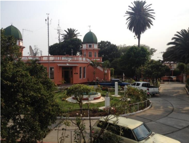
Imagen No. 24: fachada frontal de edificio principal. Fuente: Propia.
