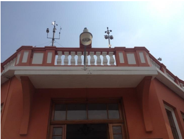
Imagen No. 21: Detalles del ingreso principal.
