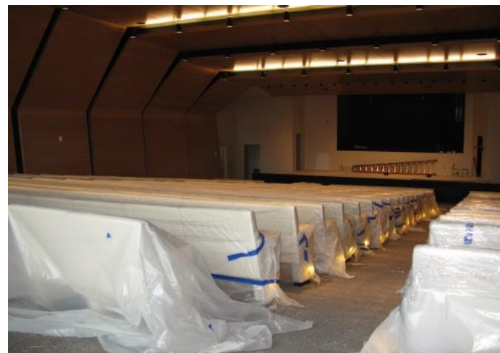
Imagen No. 107: Proceso de acabados interiores, el 29 de febrero de 2012 Fuente: http://www.ncep.noaa.gov/news/ncwcp/s064_images/s064_12_20120229.jpg
