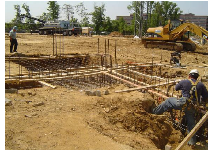
Imagen No. 95: Proceso de armazón de zapatas, el 9 de mayo de 2007. Fuente: http://www.ncep.noaa.gov/news/ncwcp/s003_images/s003o_20070515.jpg
